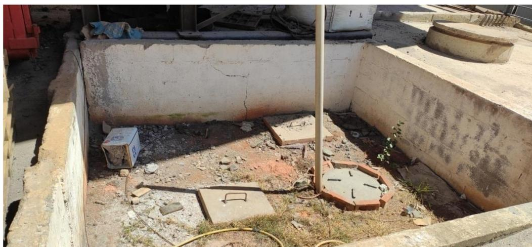
**Figura 24.** Sistema de tratamento de efluentes sanitários.
