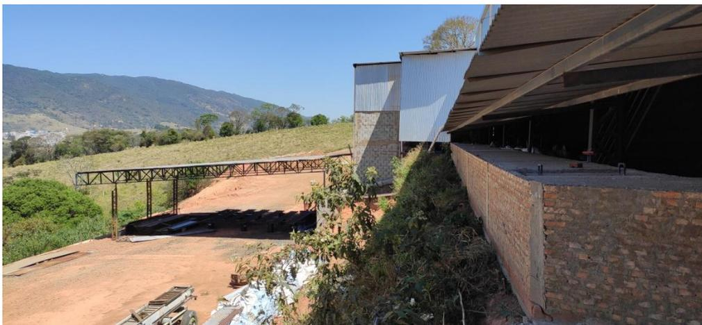
**Figura 22.** Sumidouros aos fundos do galpão ampliado. À direita, destaque para o túnel de sucção de efluentes atmosféricos do forno 3 (em alvenaria) para sistema de filtro em mangas.
