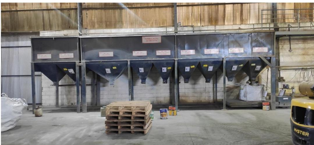
**Figura 3.** Silos de formulação de mistura
