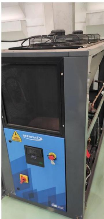
Figura 8. Refrigerador da linha instalada
