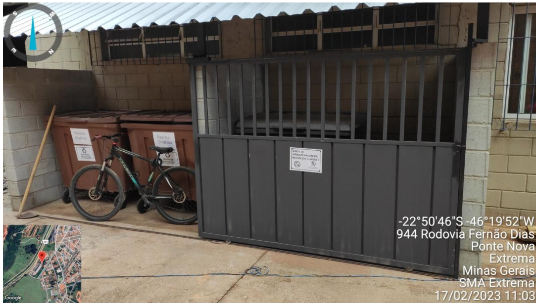
Figura 21. Armazenamento de estopas e EPIs (Classe I) e Orgânicos depois de adequação.
