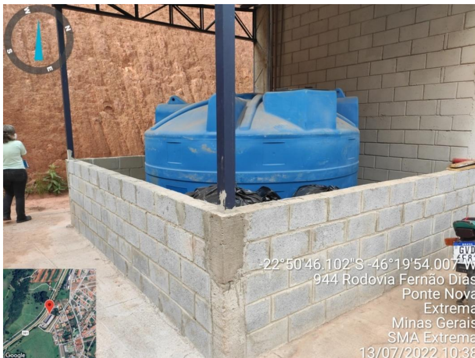
Figura 9. Tanque de contenção/armazenamento transitório de efluentes de impressão (10.000L).
