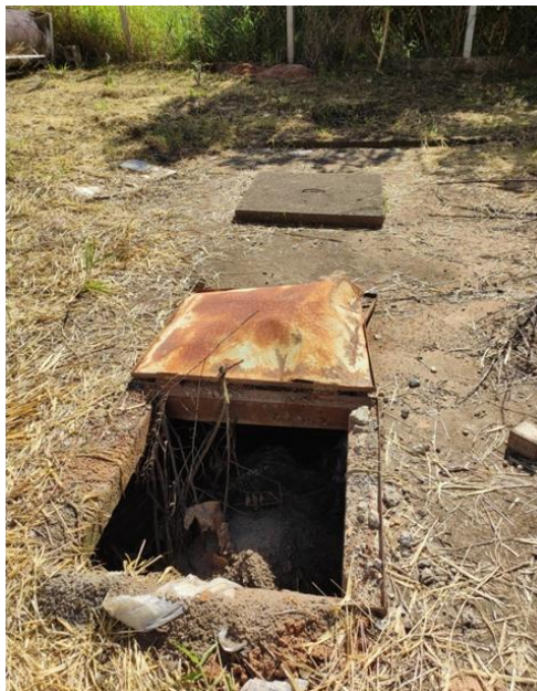
Figura 16. Sistema de tratamento de efluentes sanitários desativado do galpão nº 385
