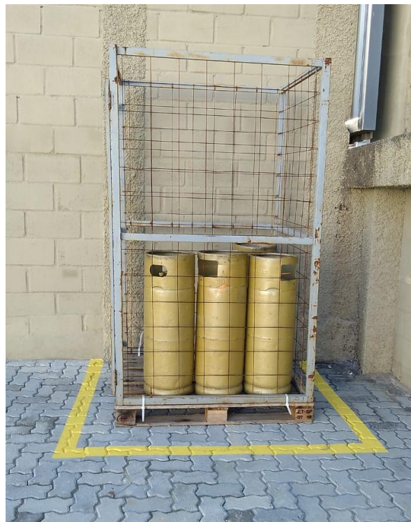
Figura 10. Local de armazenamento de botijões GLP, conforme apresentado pelo empreendedor na data de 15/06/2021.
