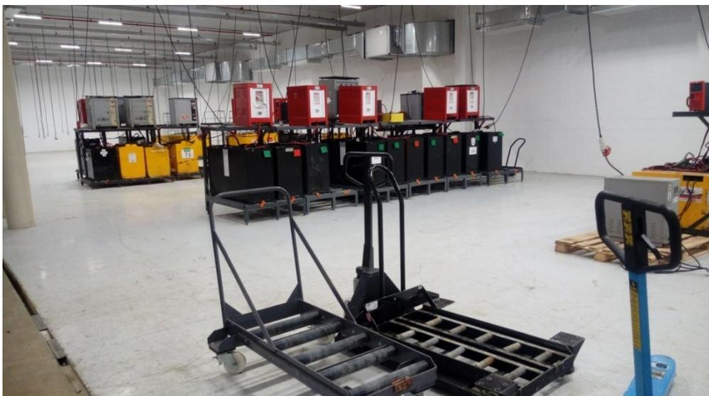
**Figura 6. Sala de carregamento de baterias**
