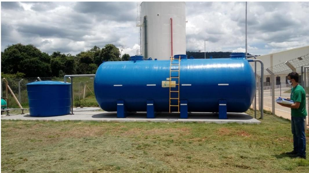
Figura 14. Estação de Tratamento de Efluentes sanitários.
