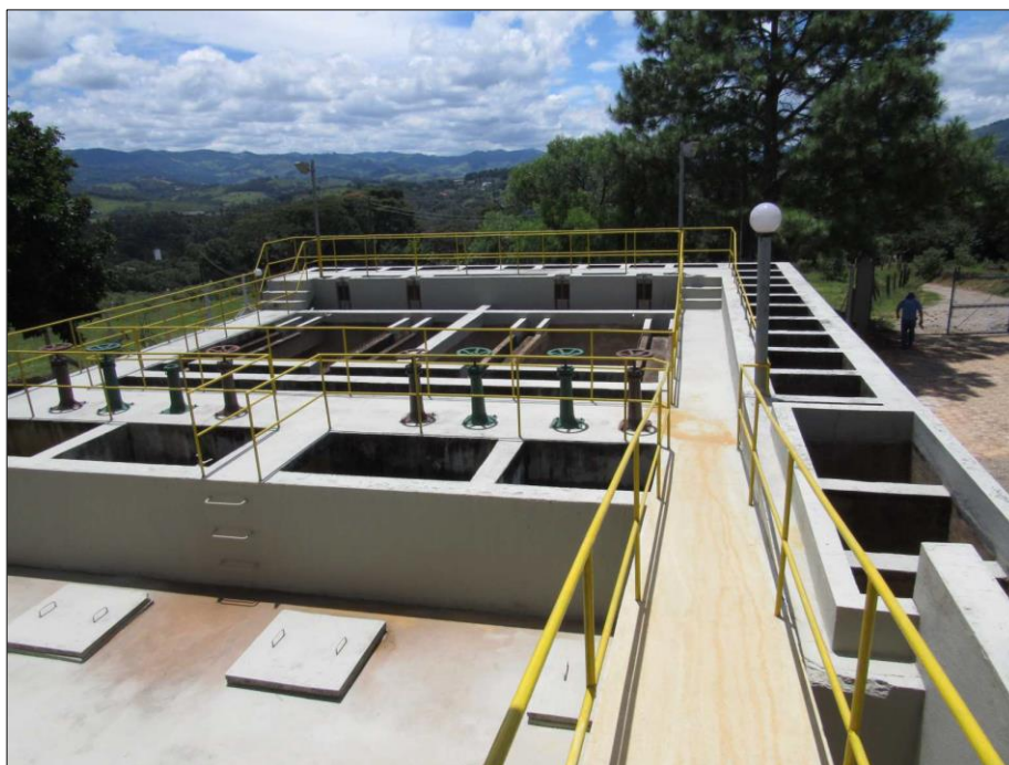
Figura 4 - Foto da ETA de alvenaria
