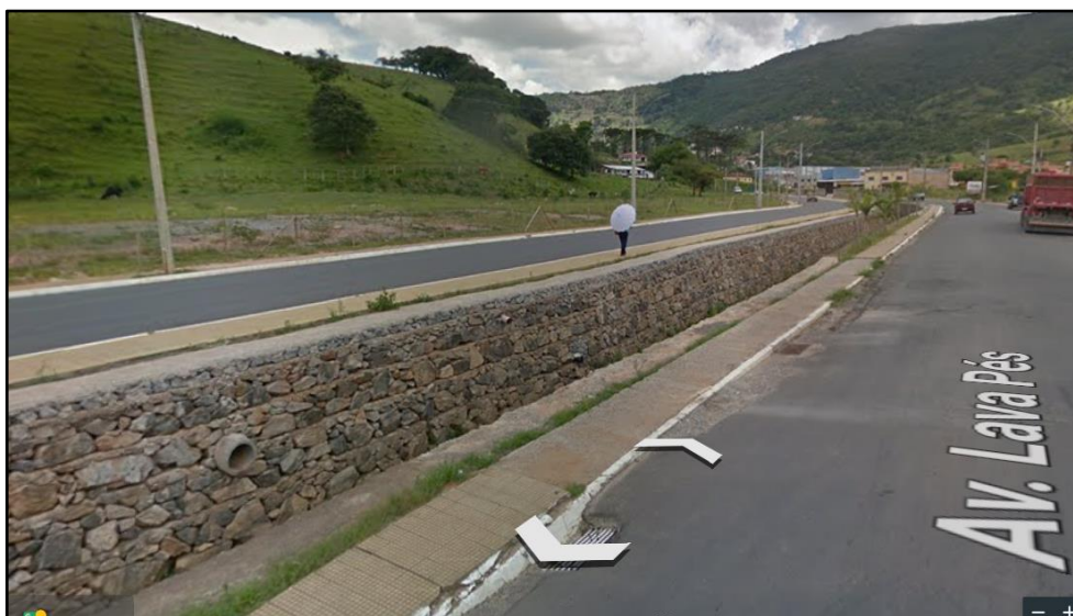
Figura 49 - Vista da Canalização localizada na Avenida Lava Pés.
