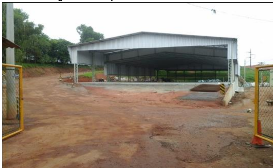
Figura 40 – Galpão do aterro sanitário
