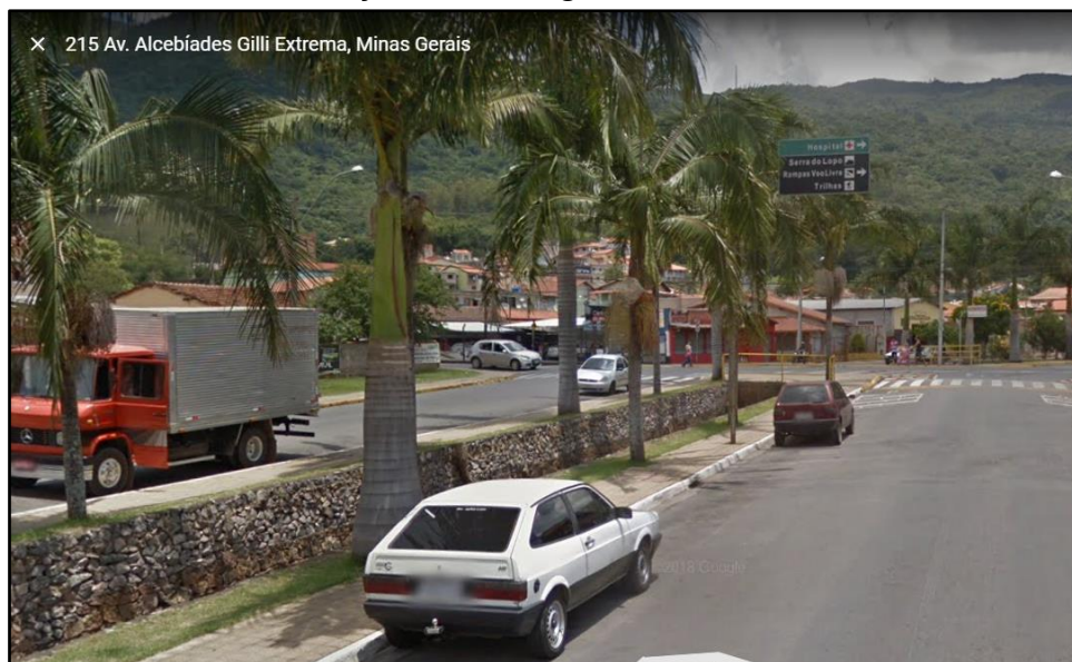
Figura 50 - Vista da Canalização do Córrego localizado na Av. Alcebíades Gilli.
