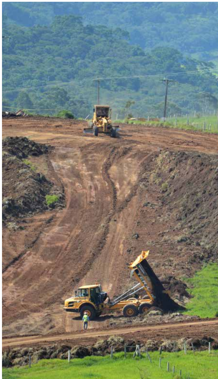
Exemplo de investimento para 2019, novo centro de distribuição (CD) da Dafiti está sendo construído no Bairro do Tenentes
