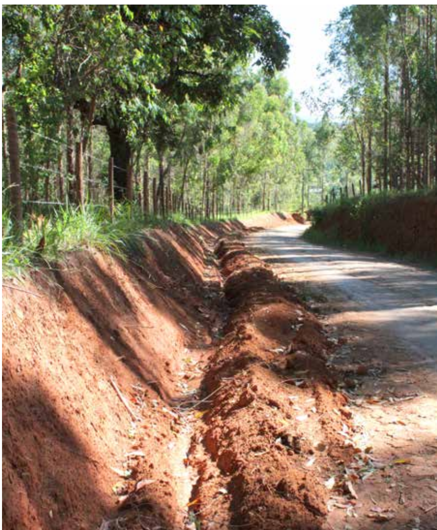
Alargamento e futuro asfaltamento da estrada Tenentes rural, que liga o Bairro do Tenentes ao Bairro São Braz
