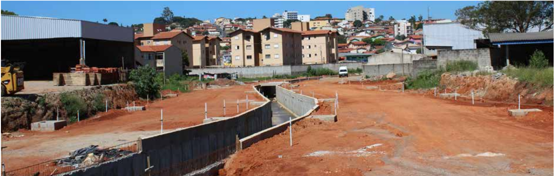
Avenida José Marques de Oliveira Neto segue em ritmo acelerado; via ligará a Av. Lavapés até a Rua Pau Brasil, no Bairro Vila Rica
