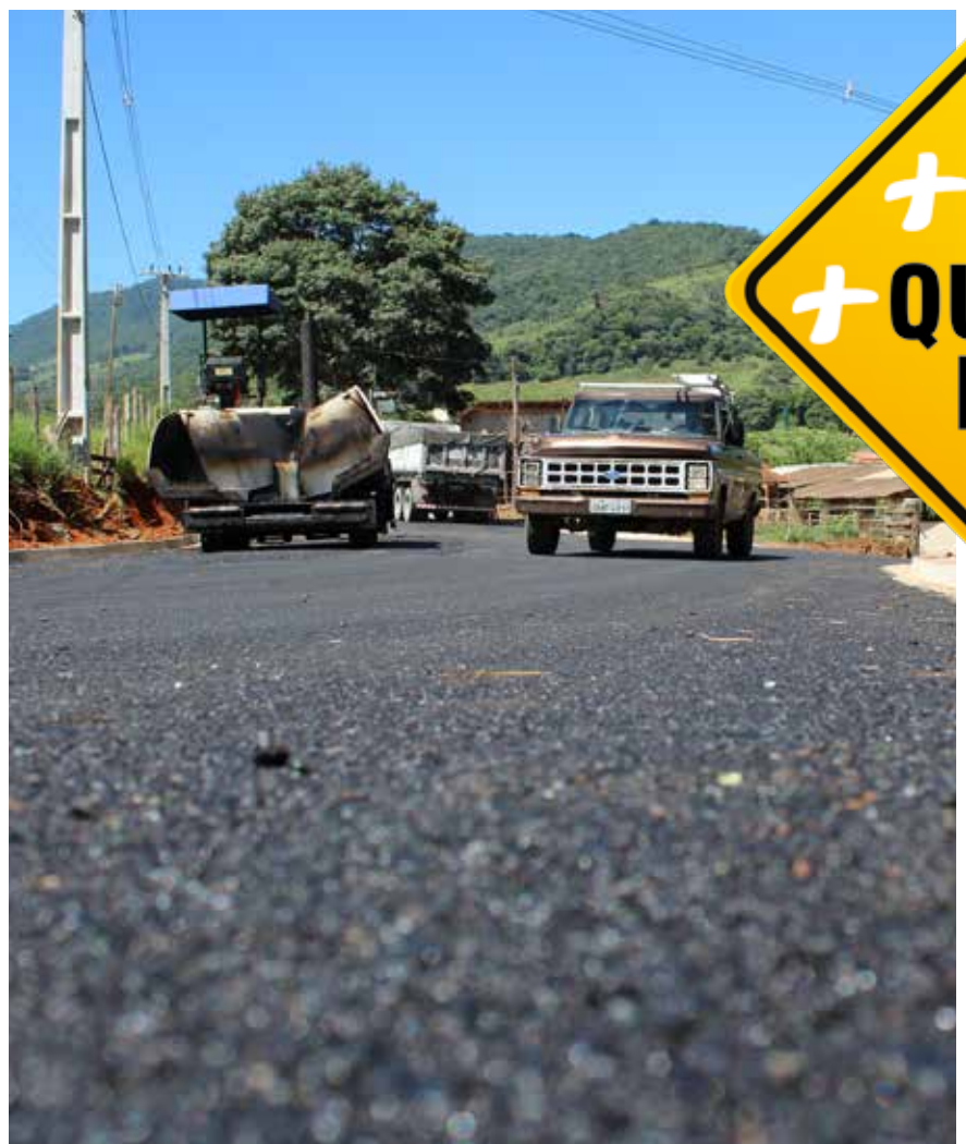
Colocação de asfalto em várias ruas do Bairro dos Forjos, incluindo no trevo de acesso ao Salto
