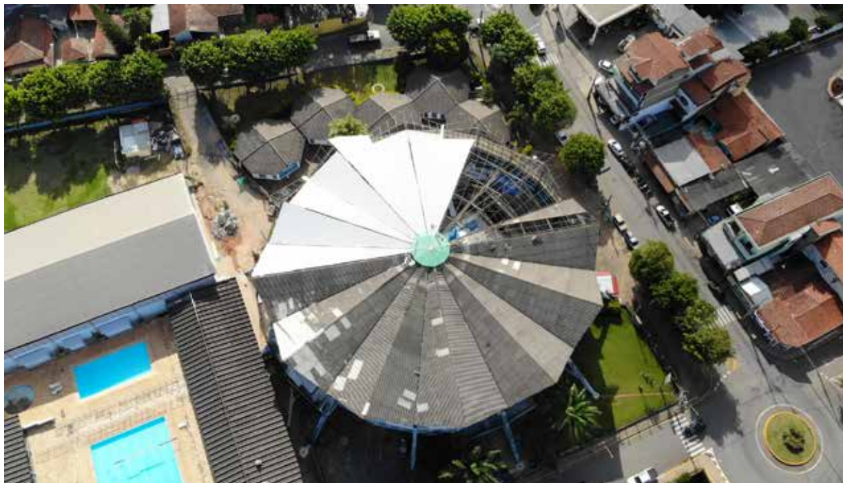
Troca das telhas faz parte de uma das maiores reformas já feitas no Poliesportivo
