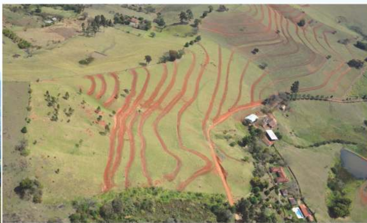
40.000 metros de construção de terraços em 100 ha
