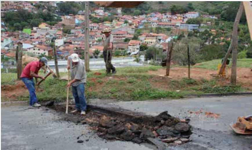
Construção de canaleta na Rua Hélio Pedroso de Alvarenga
