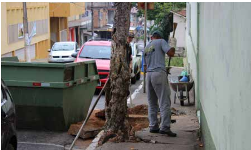
Reforma da calçada do CESEC Dom João Bosco
