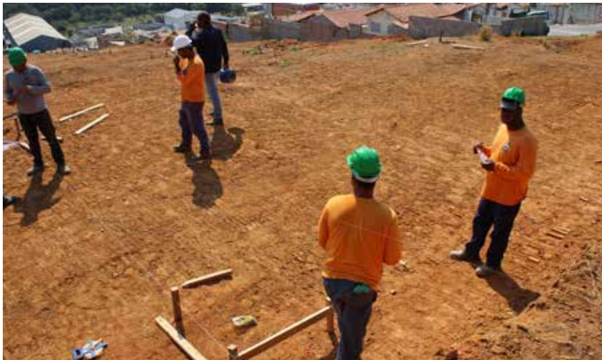
Operários trabalham nas obras do residencial Tenentes V
