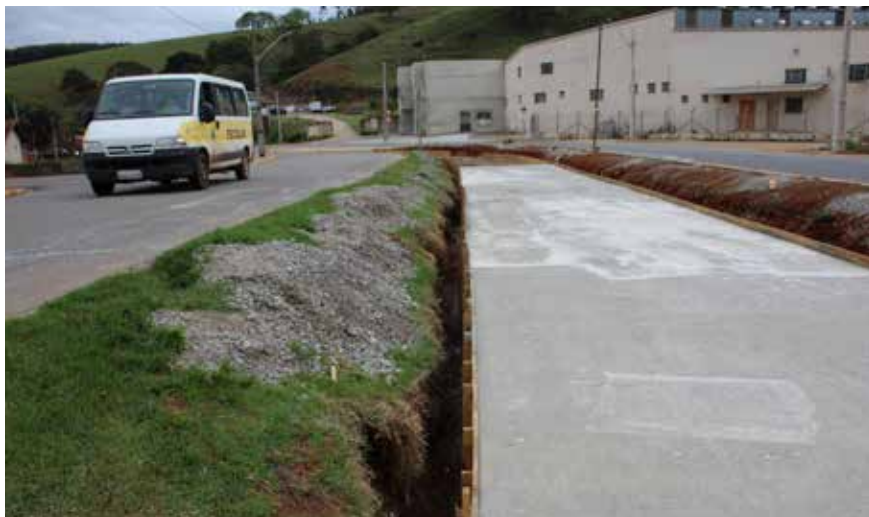
Av. Lavapés recebe obras de acesso à Avenida José Marques de Oliveira Neto, nova ligação ao Bairro Vila Rica
