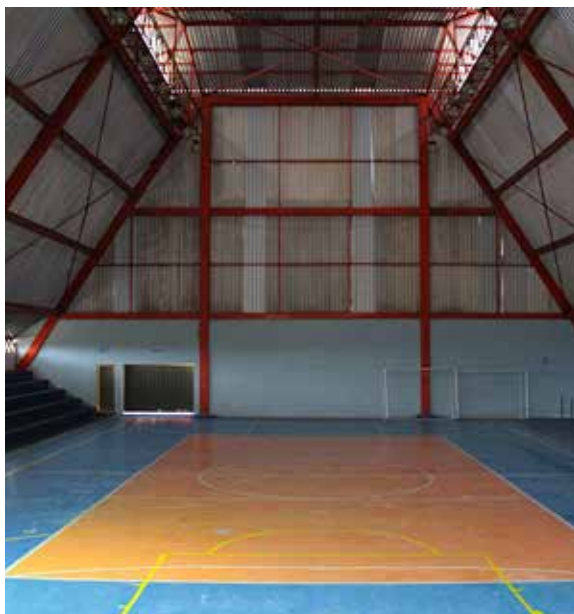
Quadra coberta está sendo reformada
