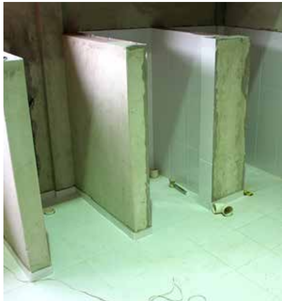
Novo vestiário está sendo construído
