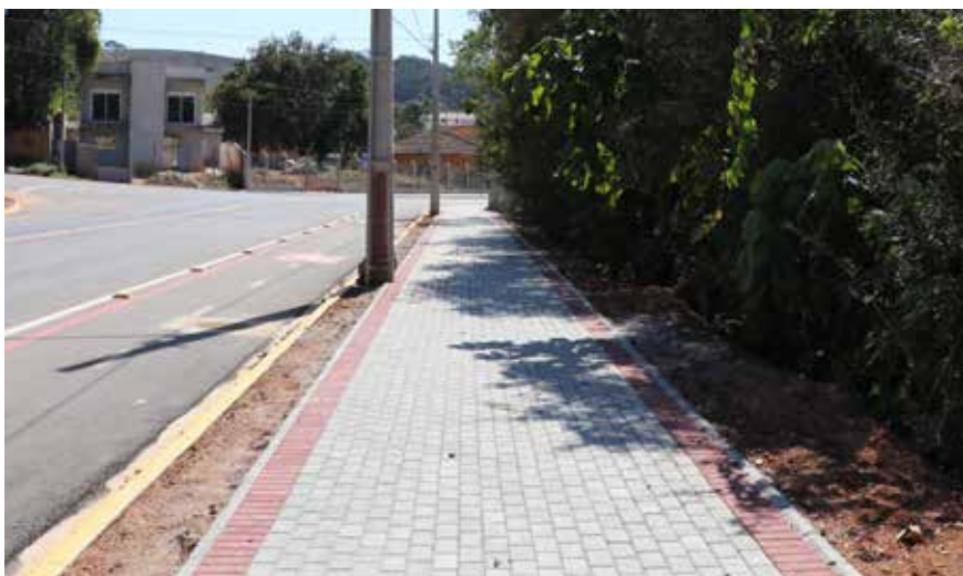
Construção de calçada na Avenida Saes Peres
