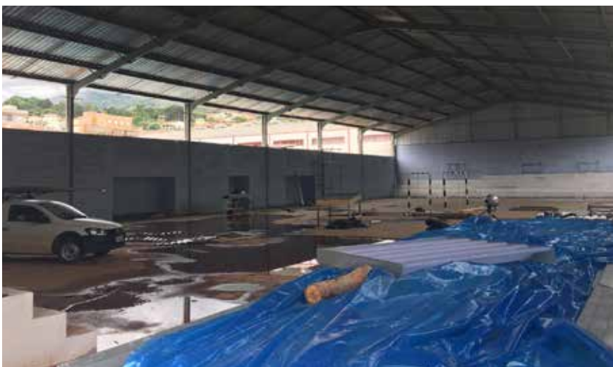
Ginásio poliesportivo em fase final de reforma
