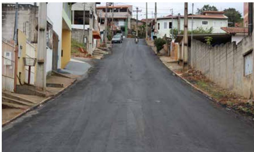
Recapeamento da Rua Paraná, no Bairro Bela Vista
