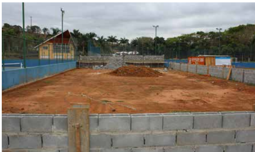
Demanda antiga dos esportistas locais, paredão de tênis finalmente está sendo construído no Parque de Eventos
