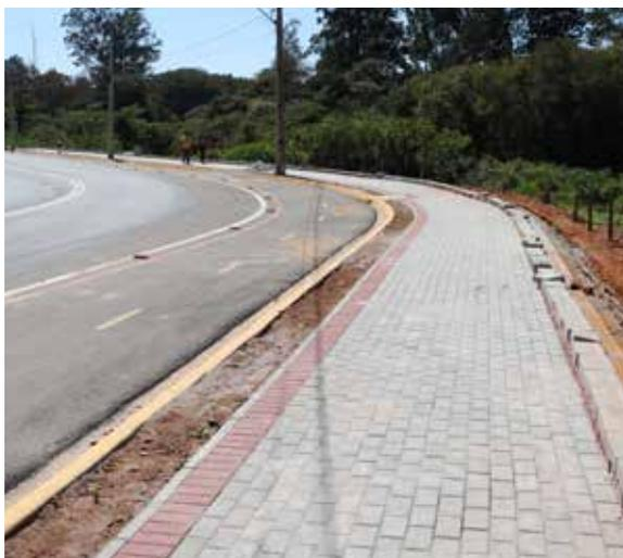
Av. Antônio Saes Peres está recebendo calçada em piso intertravado, além de obras de drenagem, águas pluviais e contenção de terra.
