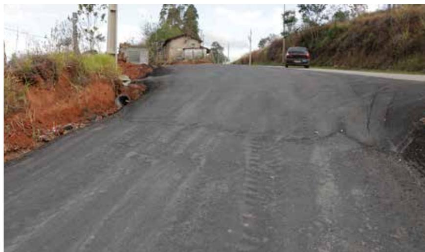
**Pavimentação do Bairros das Furnas:** 1.250 metros de asfalto, com largura média de 8 metros, além de aproximadamente 200m de obras de drenagem
