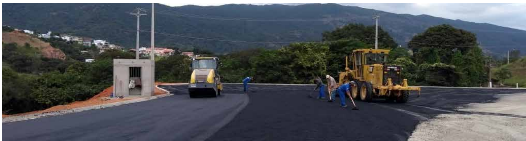
Asfaltamento no Parque de Eventos e em breve melhoria na Iluminação Pública
