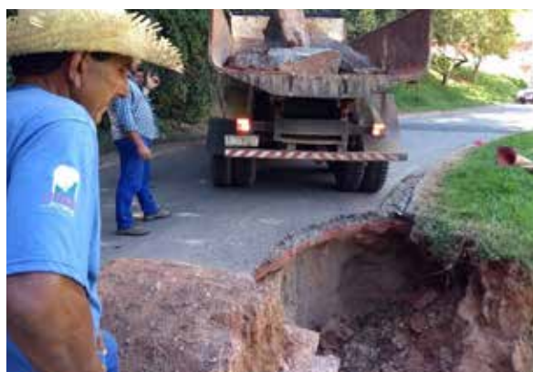
Obra de correção na erosão da Rua das Camélias provocada pelas chuvas
