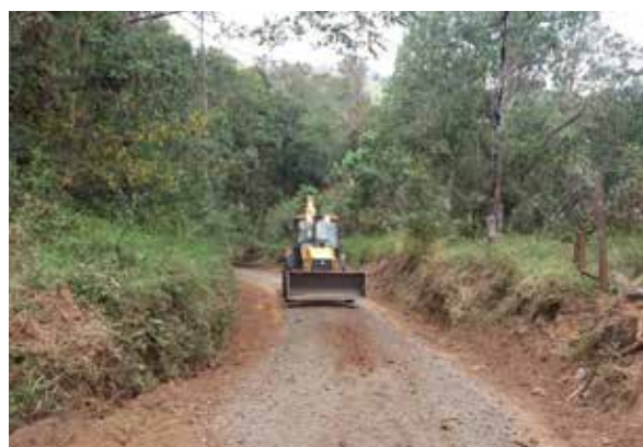
Melhorias na estrada do Lobo Guarã no Bairro Salto do Meio
