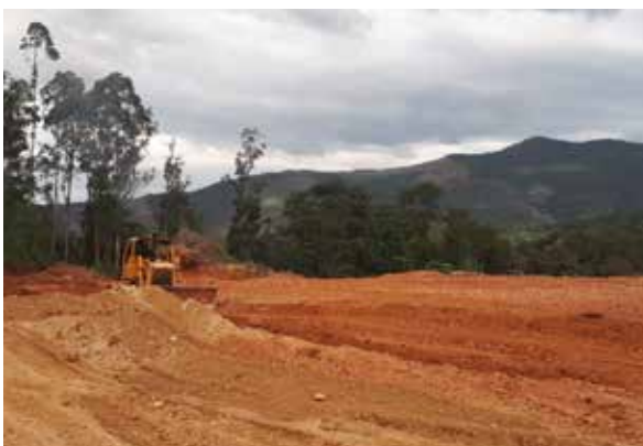
Estacionamento para carretas
