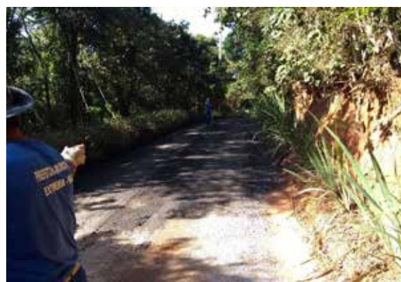
Pavimentação asfáltica na estrada que leva ao Pico dos Cabritos
