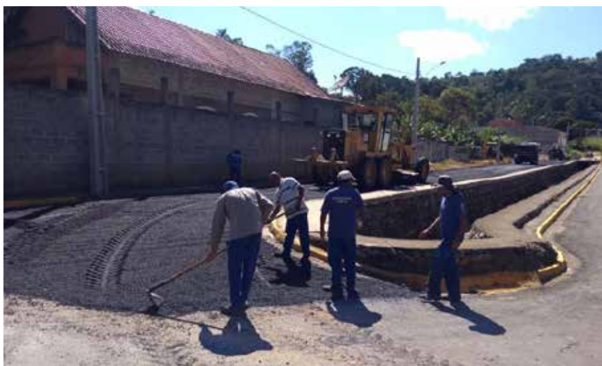
Asfaltamento na Rua Alfredo Olivotti Neto
