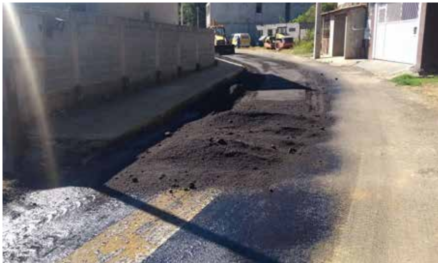
Recapeamento na Rua José Franklin Vieira da Silva no Bairro Vila Rica
