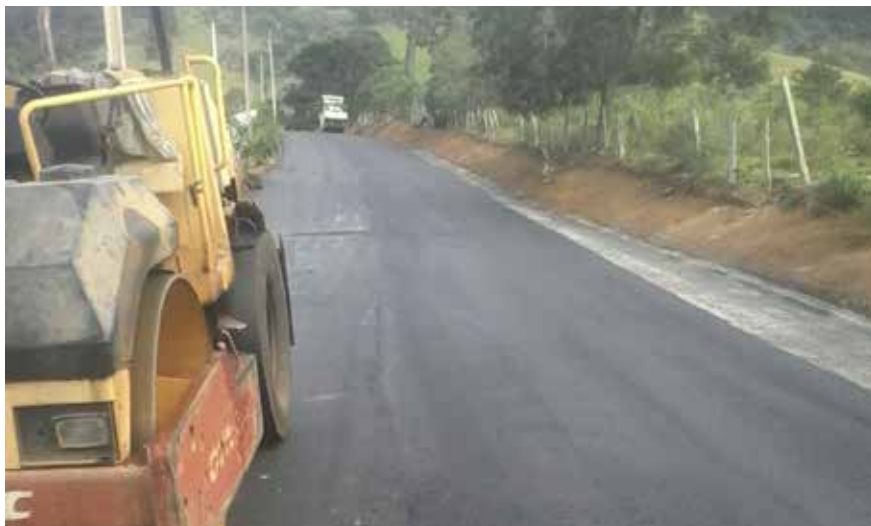
Asfaltamento chacreamento Santa Rita no Bairro Salto
