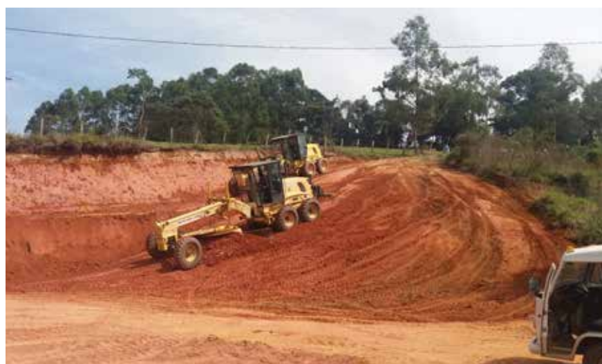
Terraplanagem para nova quadra Poliesportiva no Bairro das Furnas
