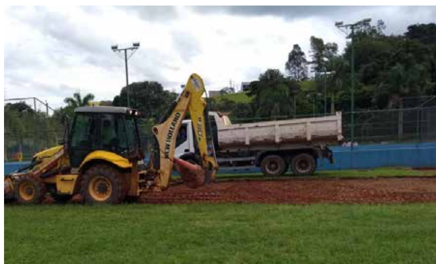
Construção do Paredão de Tênis no Parque Municipal de Eventos
