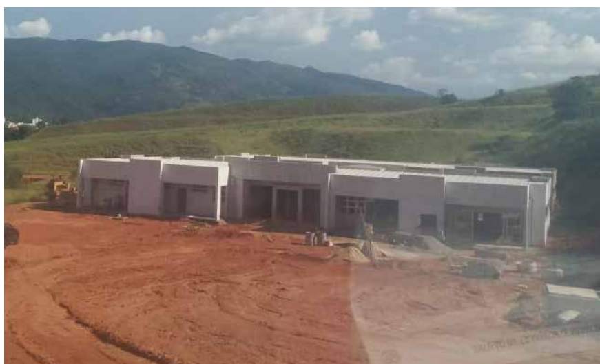
Construção do Ceim Pró-Infância no Bairro dos Tenentes
