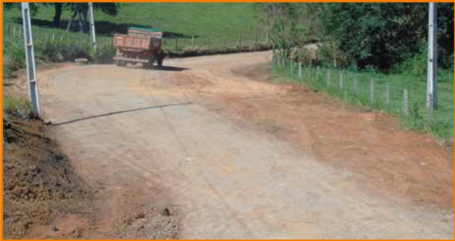
Alargamento da R. Vereador Odacyr Bueno de Andrade | Ponte Nova
