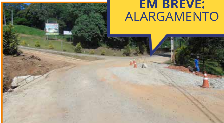
Reconstrução da Ponte Estrada Municipal Fazenda Fabiano em aduelas de concreto (canalização em formato de ponte)
