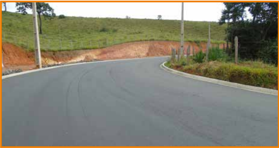
Alargamento, pavimentação, drenagem e construção de guias da Estrada Municipal Remígio Olivotti
