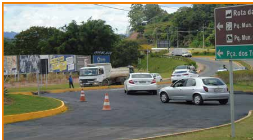
Asfaltamento do Trevo da Av. Nicolau Cesarino
