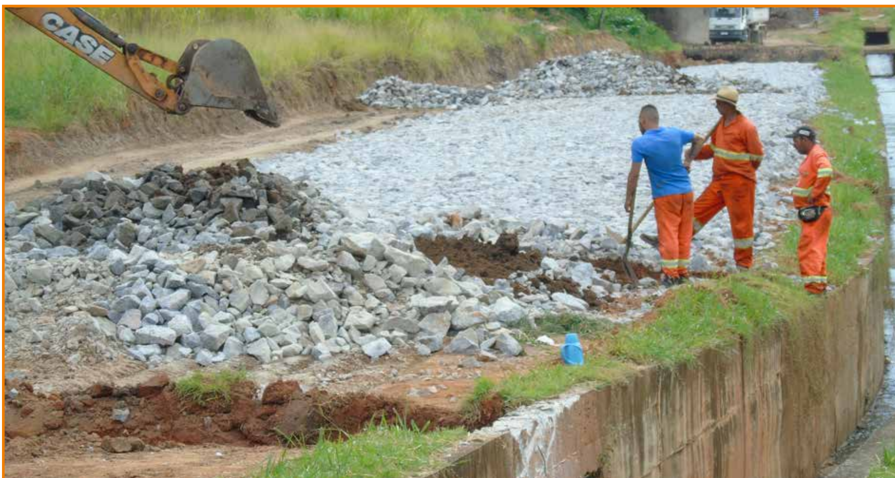
3ª Fase da Av. Lavapés
