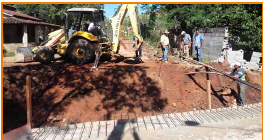
Reconstrução da Ponte dos Pires
