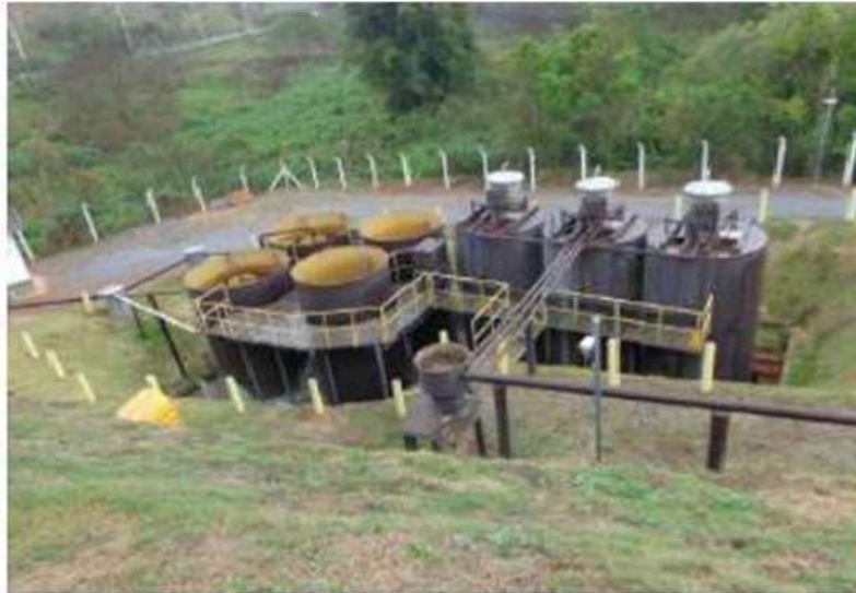
Vista aérea ETE Roseiras
