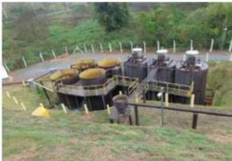
Vista aérea ETE Roseiras
