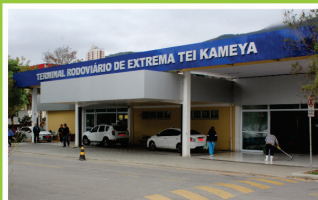
REESTRUTURAÇÃO - Reforma da Rodoviária
